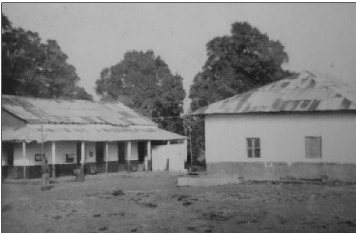
Foto 3 – Xime/1972 – No edifício da esquerda funcionava a secretaria, uma arrecadação, o armeiro e o quarto do Guia Malan [parte visível]. Nas traseiras; o quarto dos 1.ºs. Sarg. Bagorro e Simões, o bar/messe de sargentos, o WC e um pequeno abrigo de apoio. O edifício da direita estava dividido em quatro partes e era ocupado por furriéis. No quarto da esquerda, a que corresponde a janela sem protecção, residiam o C. Ferreira, o J. Godinho e o J. Araújo, trio de comando do 1.º GComb.
