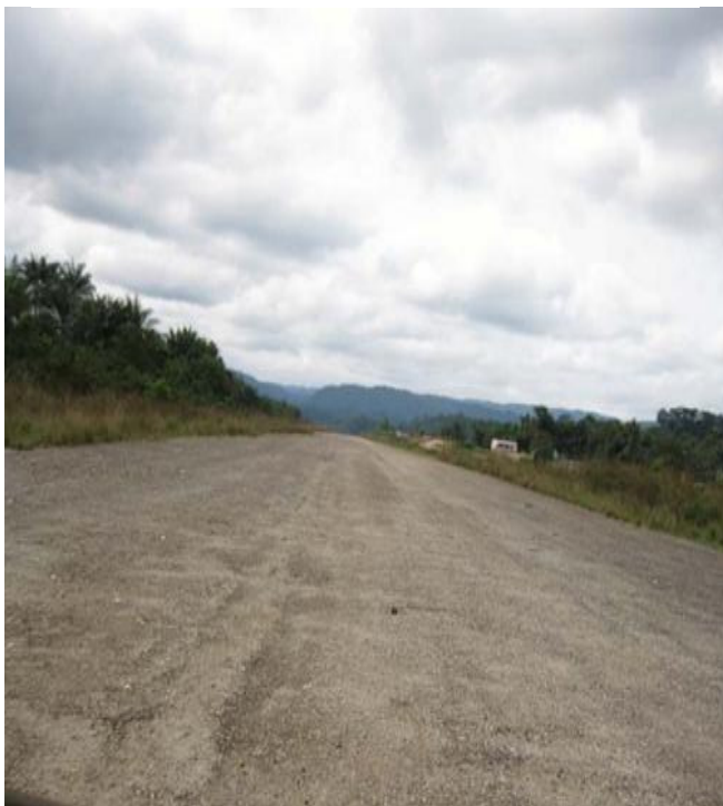
Fig. 43– A pista para apoio aéreo que o meu Batalhão ajudou a construir (foto António Liberdade, 13 de Setembro 2009)
