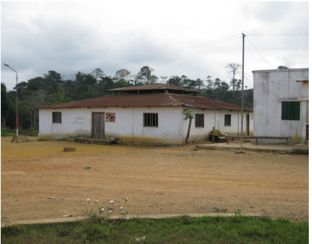
Fig. 92— Algumas das nossas instalações no «quartel-velho» (foto António Liberdade, 23 de Outubro 2009)
