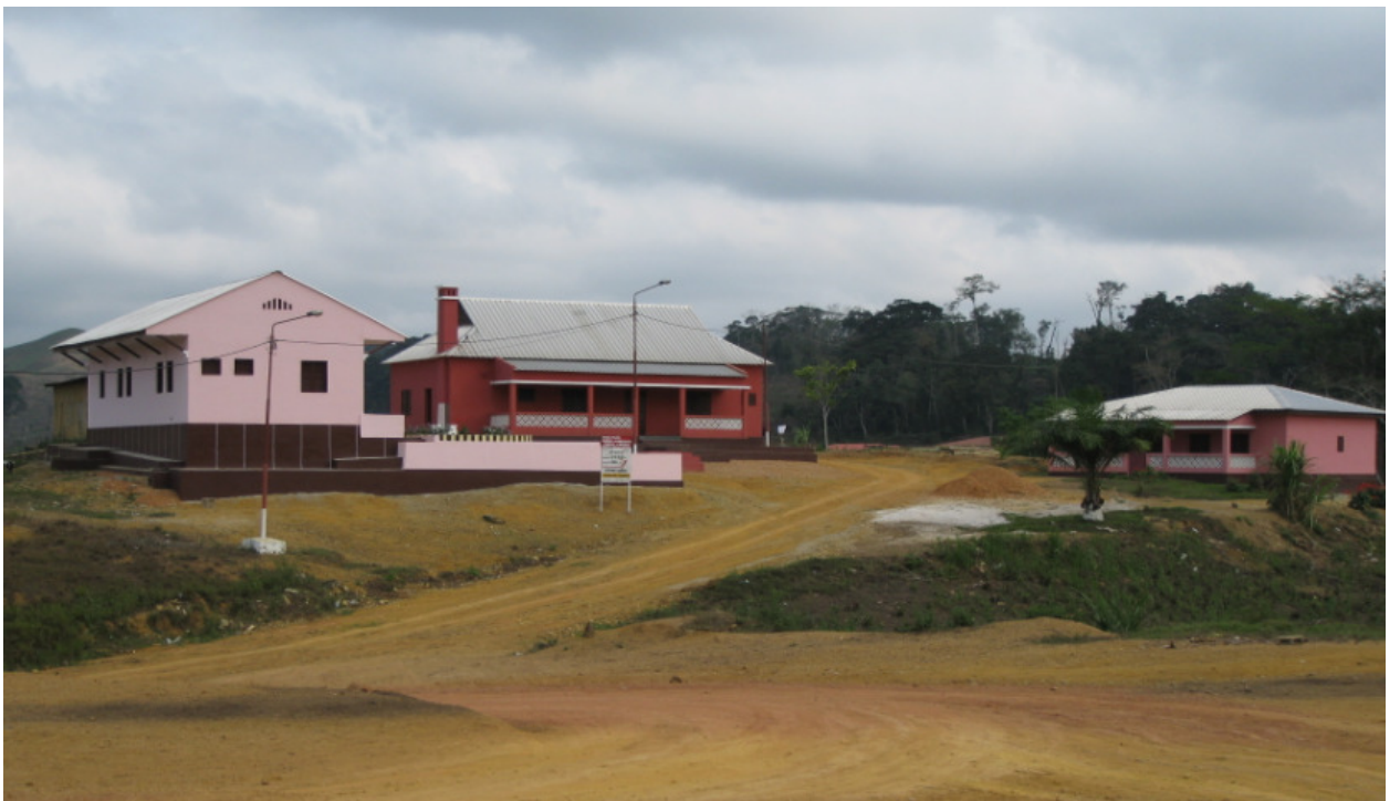
Fig 93.- Instalações do « quartel-velho» recuperadas para fins administrativos e sociais (foto António Liberdade, 23 de Outubro de 2009)
