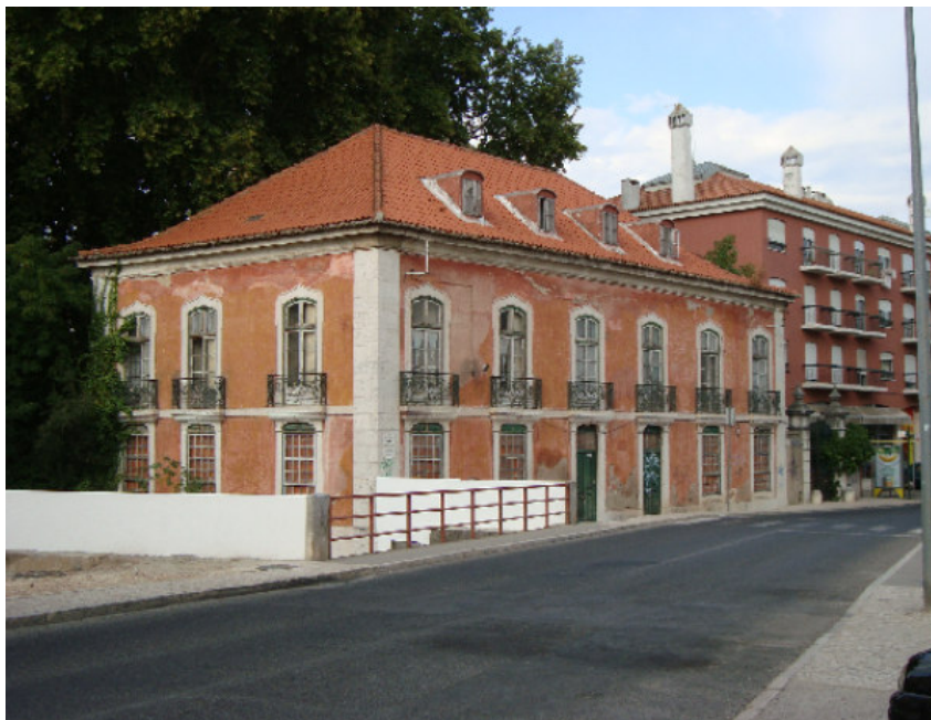
© Foto do Autor (12/9/2009) – Edifício em degradação.
