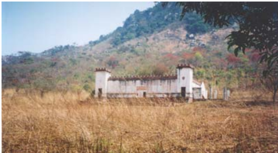
Molumbo, 2004. A velha prisão, ainda de pé, mas muito mal tratada interiormente
