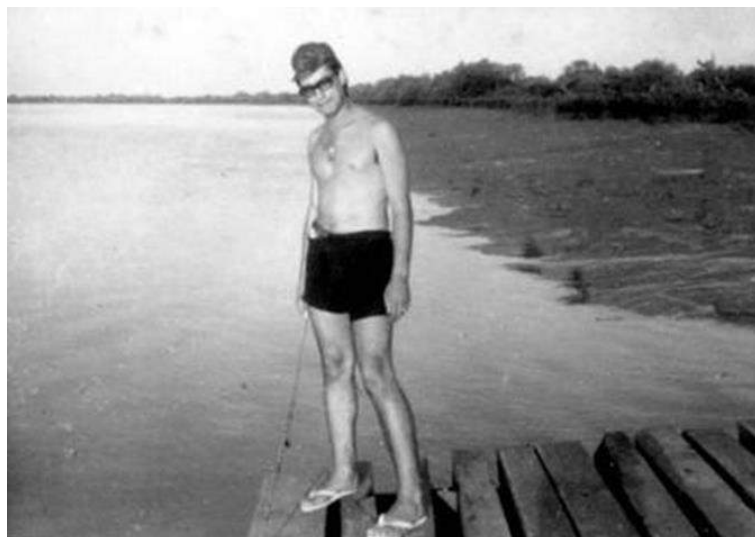
... “Maçarico” na ponte-cais do Enxudé, Out64
